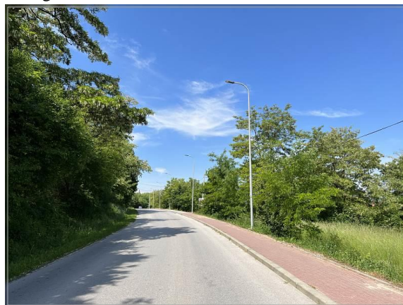
f/ Przebudowa oświetlenia ulicznego, ul. Radkowska.
